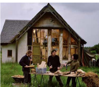
Auto-construction en paille Saint-Germain-d'Arcé
