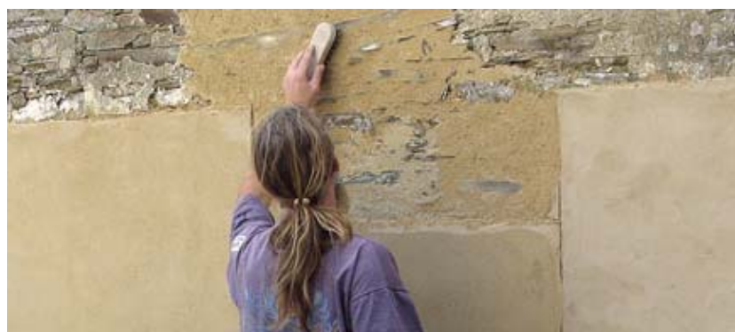
Redécouverte des savoir-faire traditionnels : réfection d'enduits chaux ou terre
