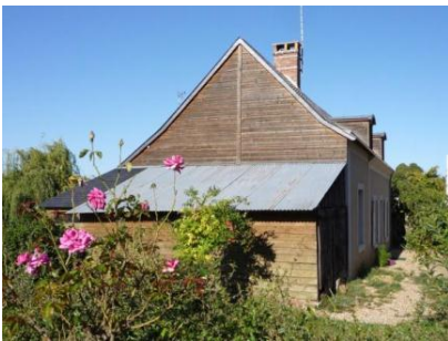
Extension d'une maison traditionnelle - Le Grand-Lucé
